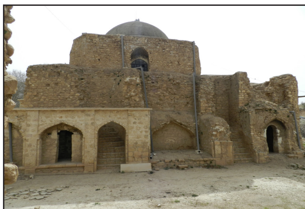
تصویر ۱۳. نحوه قرارگیری پلکان در بنای خرّقه (عکس از: نگارندگان، ۱۳۹۵).
