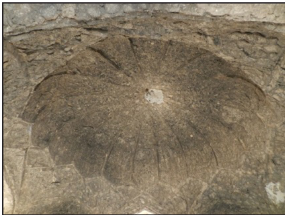
تصویر ۱۵. کاربندی گنبد چهارطاقی سلامت‌آباد (عکس از: نگارندگان، ۱۳۹۵).
